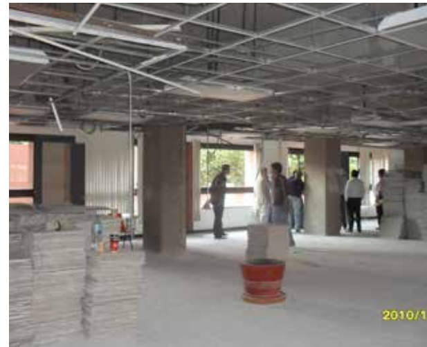
Primeras adecuaciones del espacio para las cabinas de UAM Radio
