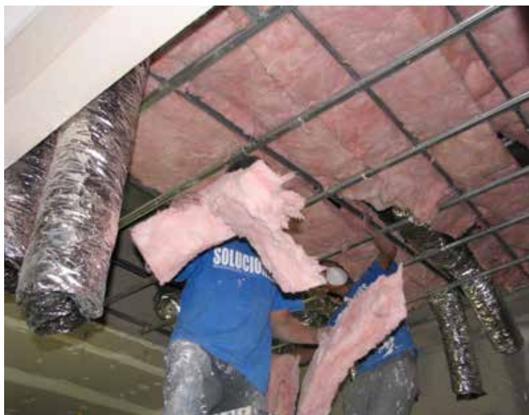
Colocación de aislante en cabinas de producción
