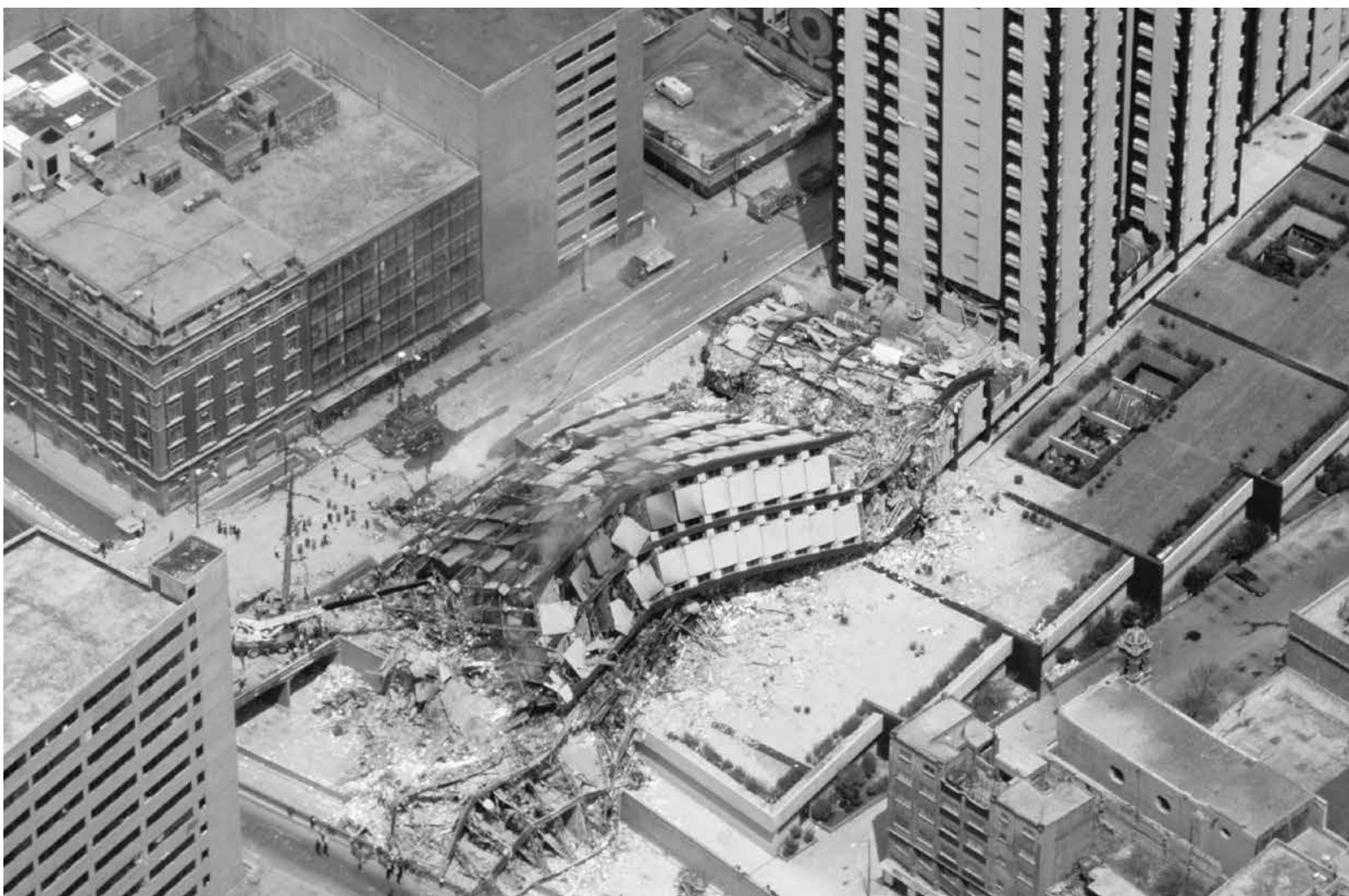
Equipos de rescate buscan supervivientes en los restos de un edificio del Conjunto Pino Suárez en la ciudad de México en 1985. (Fotografías: John Barr/Liaison)
