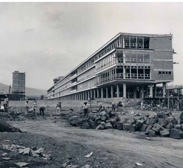
Fotografías de la construcción de Ciudad Universitaria: bit.ly/t0eaEN
