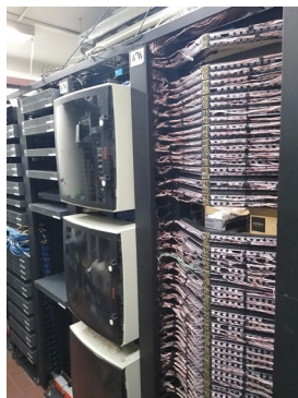
Conmutador equipos centralizados
